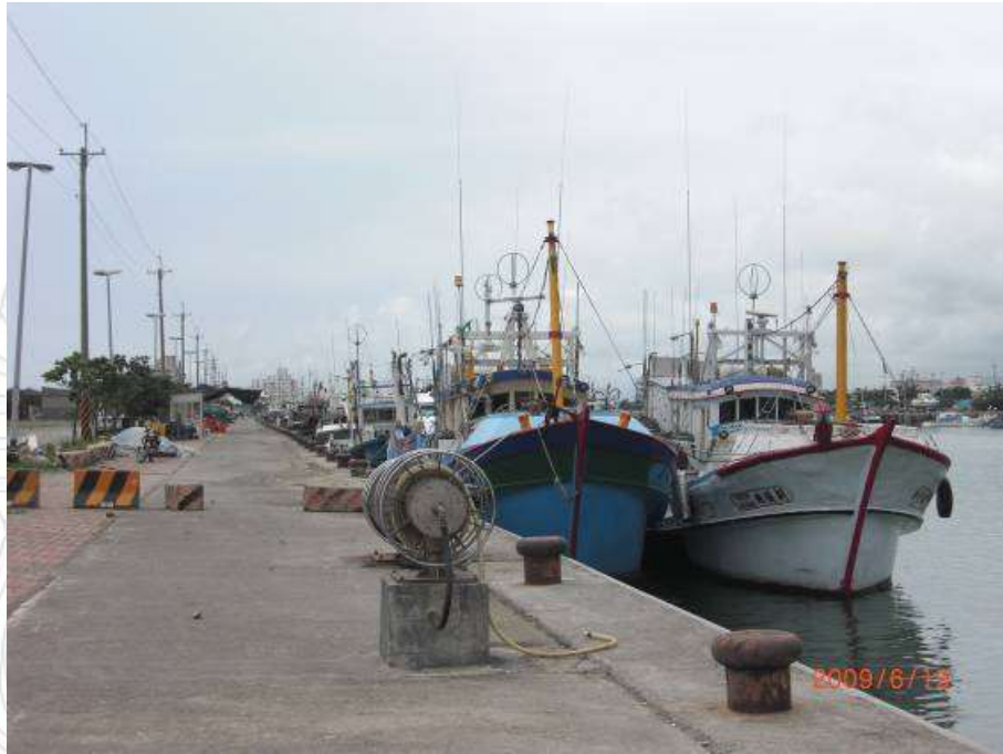
加水設施(烏石漁港)
