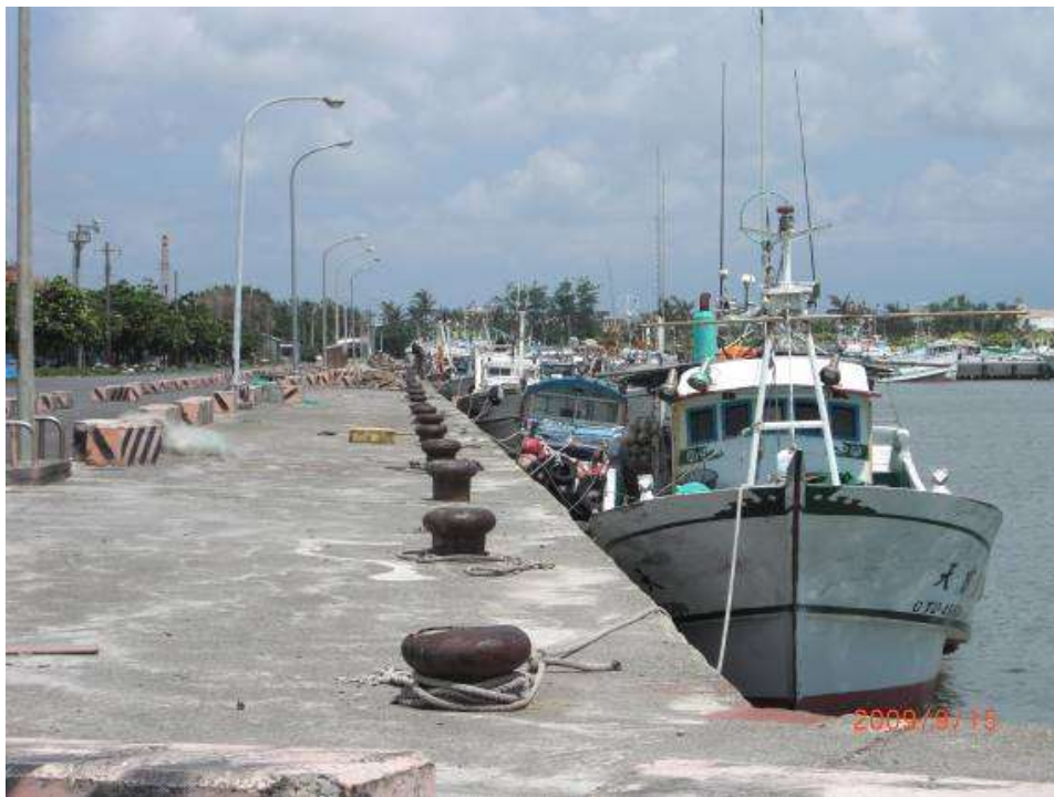
電力設施(鹽埔漁港)
