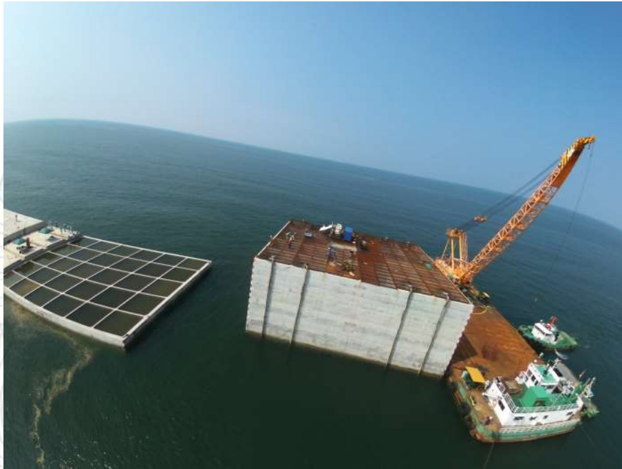
沉箱設置灌水沈設圖
